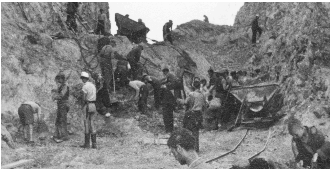
Jüdische Zwangsarbeiter auf der Baustelle in Karya, 1943 © Sammlung Andreas Assael
