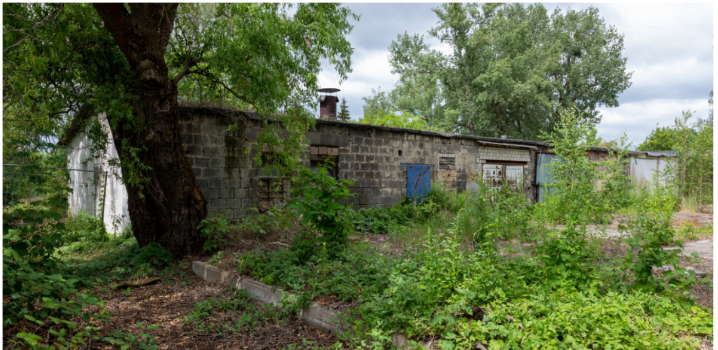
Baracke Landweg 3/5a des ehem. Kriegsgefangenenlagers Lichterfelde, 2022 © Dokumentationszentrum NS-Zwangsarbeit, Bild: Antonia Weiß
